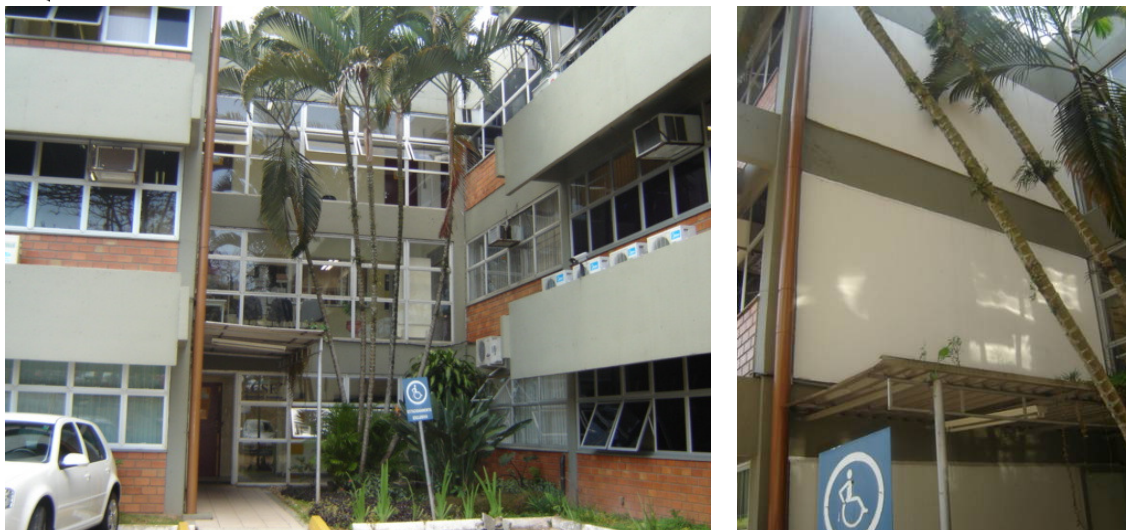
Fotos 145 e 146 – Fachada Norte 1 – Acesso ao Bloco C.
