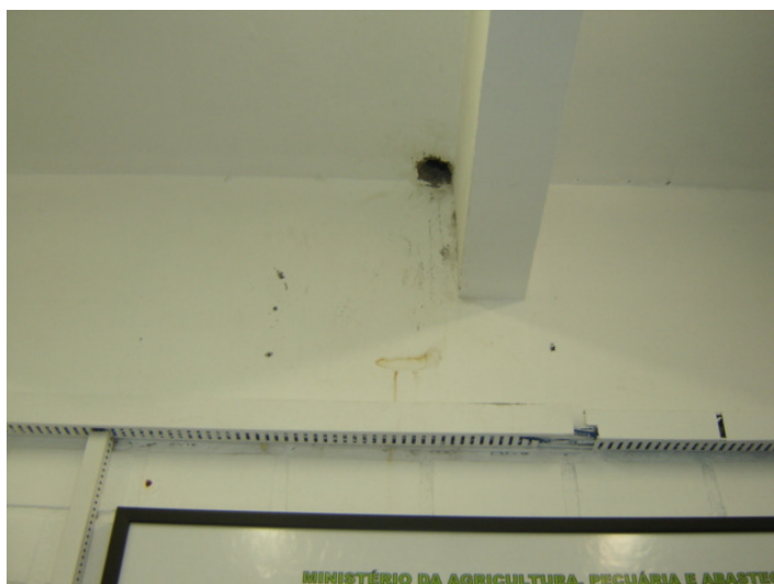
Foto 130 – Infiltração.
