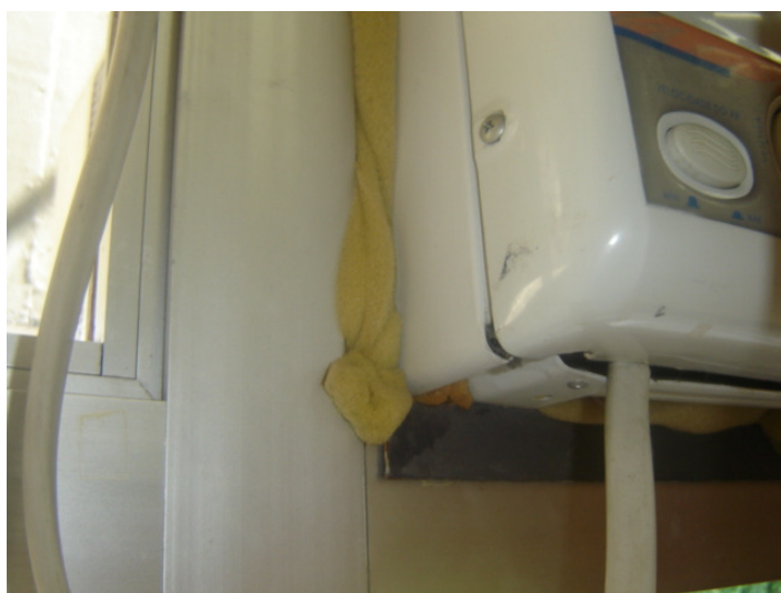
Foto 134 – Vedação inapropriada.
