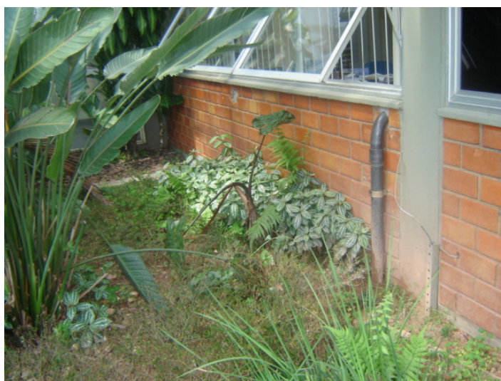
Fotos 148 e 149 – Fachada Norte 1.
