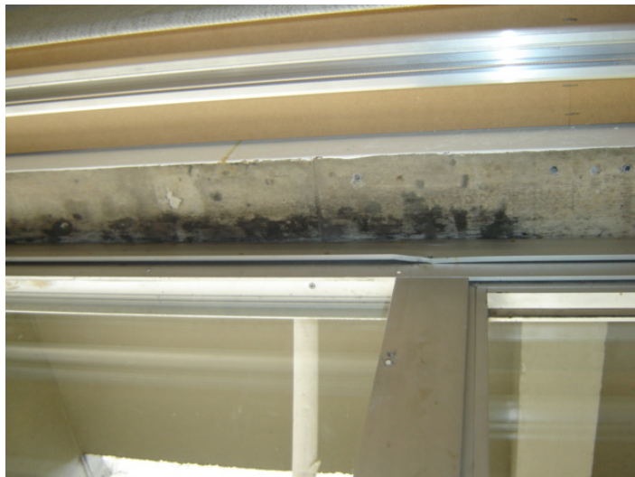
Foto 135 – Infiltração.
