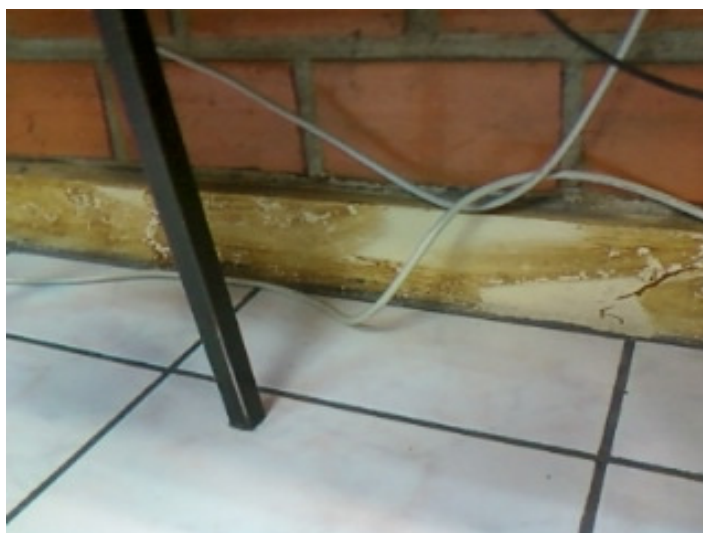
Foto 103 – Retoque de pintura no rodapé.
