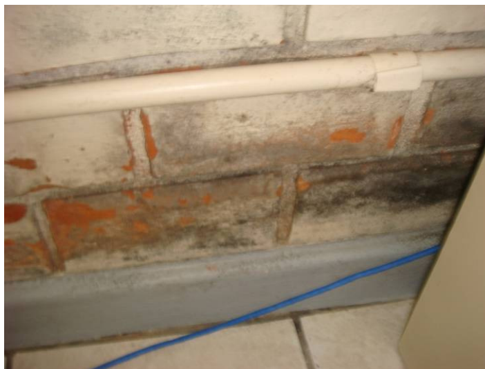
Foto 06 – Infiltração.
