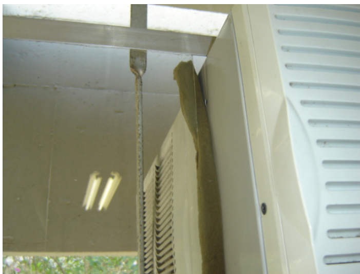
Foto 119 – Vedação da janela com espuma.
