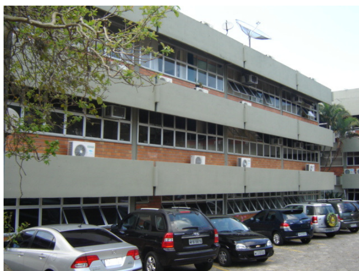
Foto 144 – Fachada Norte 1 (estacionamento).
