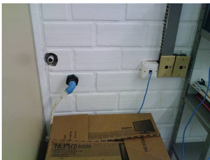
Foto 102 – Tubulação de água.
