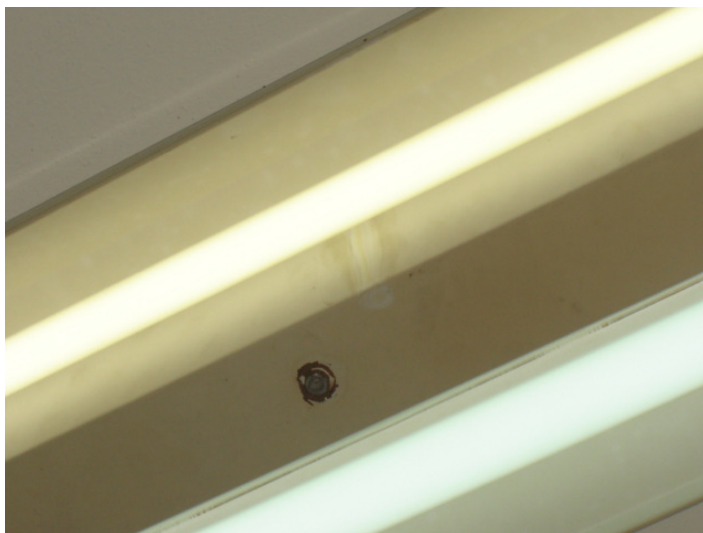
Foto 124 – Goteira na luminária.
