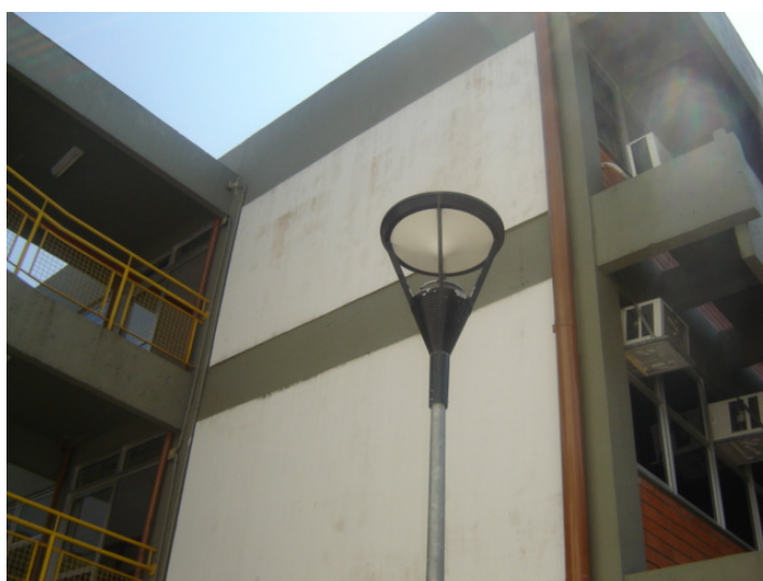
Foto 155 – Fachada Sudoeste – Ligação ao Bloco Central.
