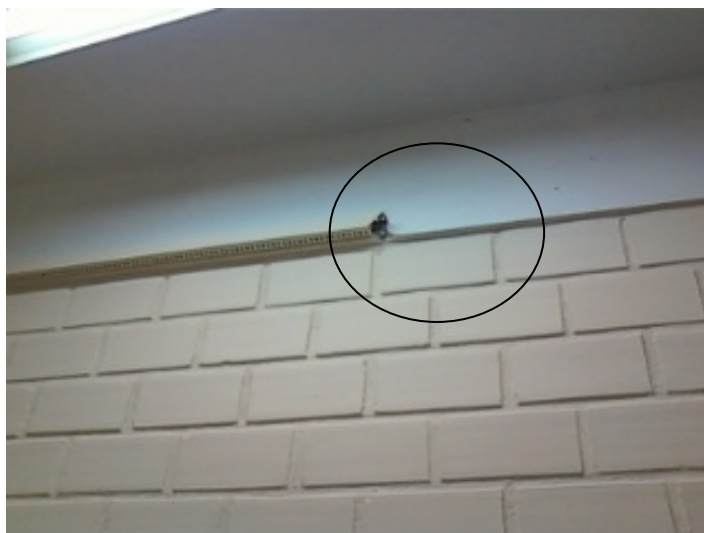
Foto 71 – Calha danificada.
