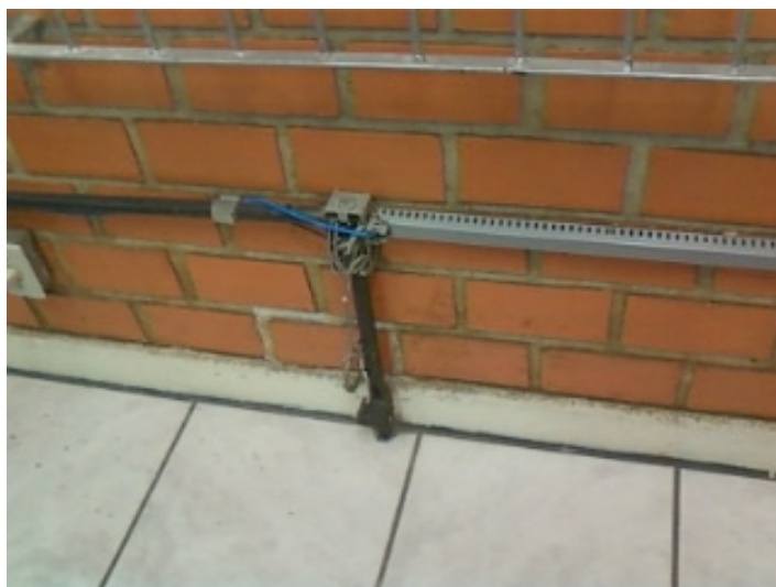
Foto 39 – Calha danificada.
