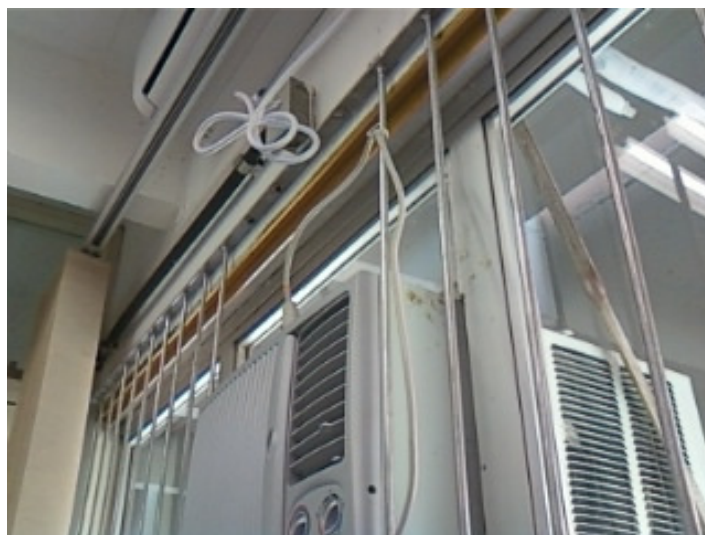
Foto 40 – Retirada da calha.
