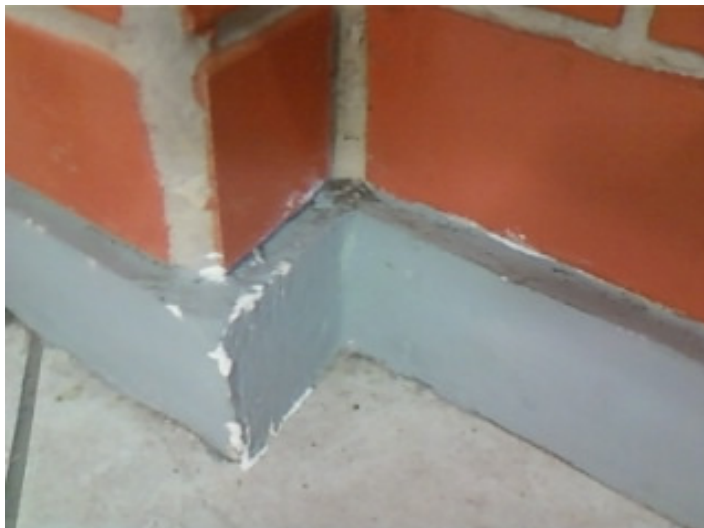
Foto 29 – Retoque de pintura.
