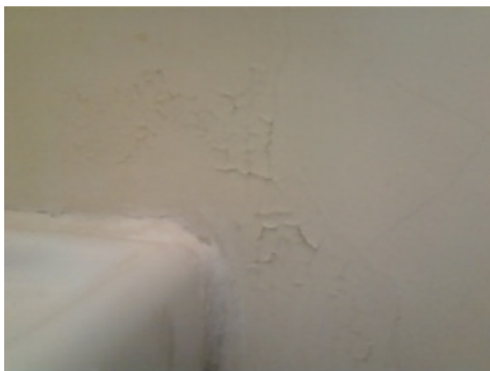
Foto 28 – Infiltração.
