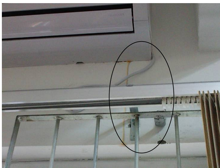
Foto 82 – Infiltração.
