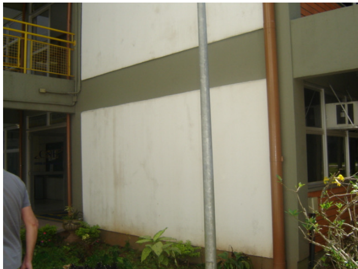
Foto 156 – Fachada Sudoeste – Ligação ao Bloco Central.
