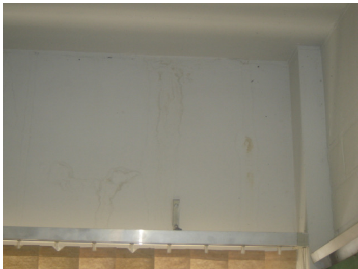
Foto 108 – Infiltração.
