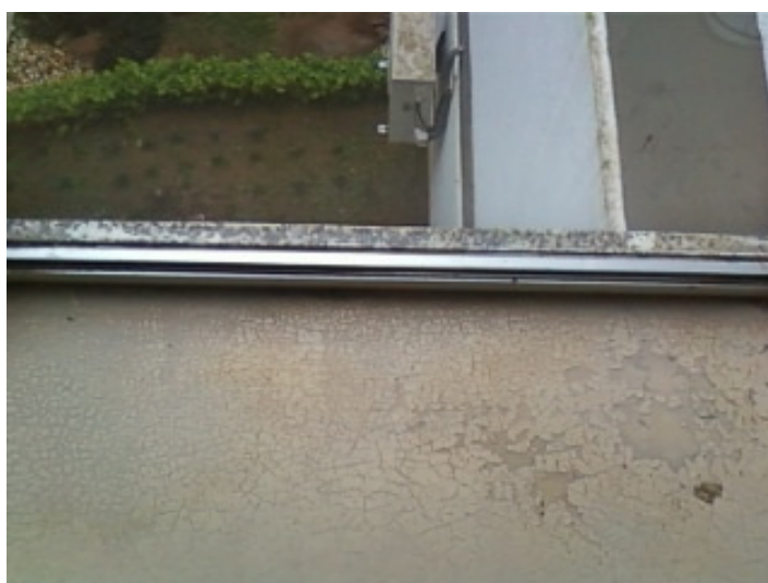
Foto 95 – Piso Epóxi com manchas.
