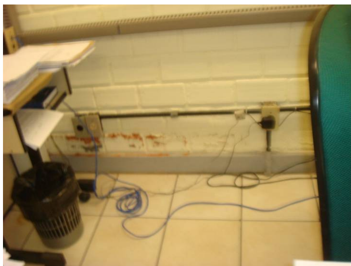
Foto 22 – Infiltração.
