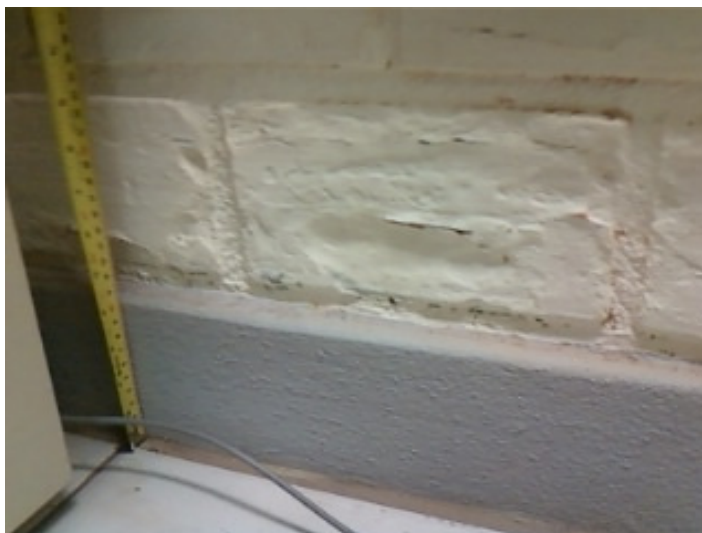
Foto 31 – Infiltração.
