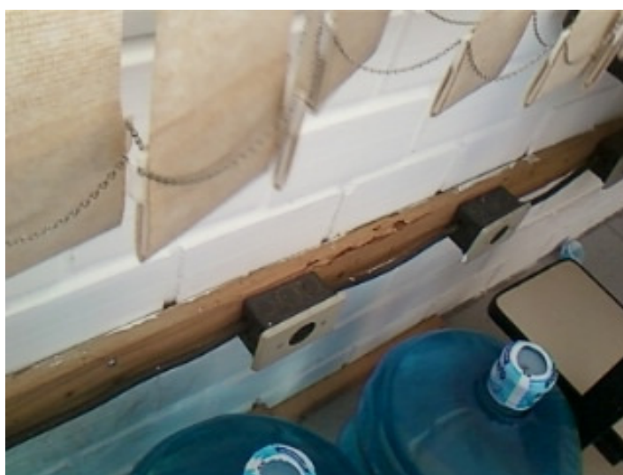
Foto 52 – Tomadas fixadas na régua de madeira.
