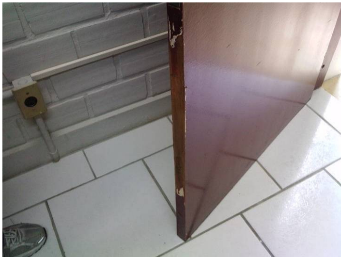
Foto 93 – Retoque de pintura.
