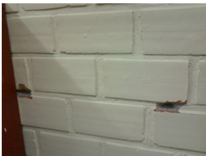
Foto 97 – Alvenaria danificada.
